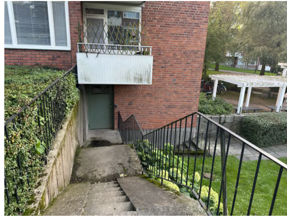
Trappor och räcken runt husen rivs innan dräneringsarbetet och återskapas på samma plats
