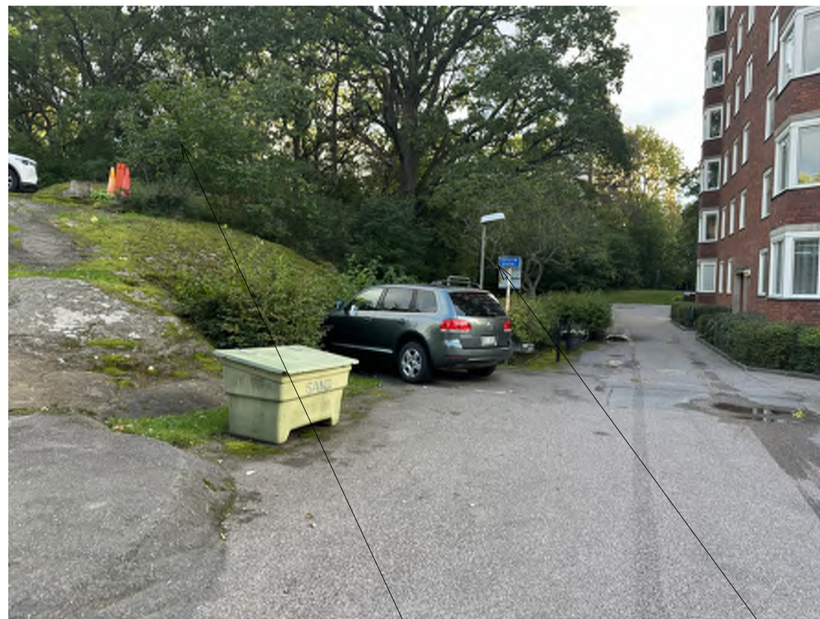
Berg rivs för att ge plats åt nya parkeringsplatser och ny trappa mellan övre och nedre parkering
