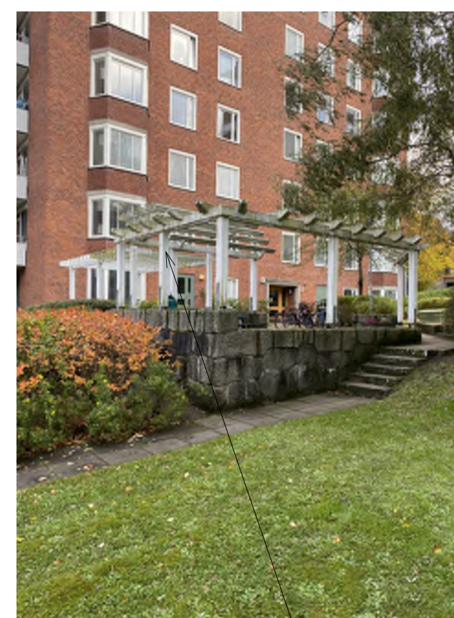
Demontering av lägre delen av befintlig pergola, förvaring, rengöring och återmontering, samt ommålning av hela pergolan i kulör lika befintligt.
