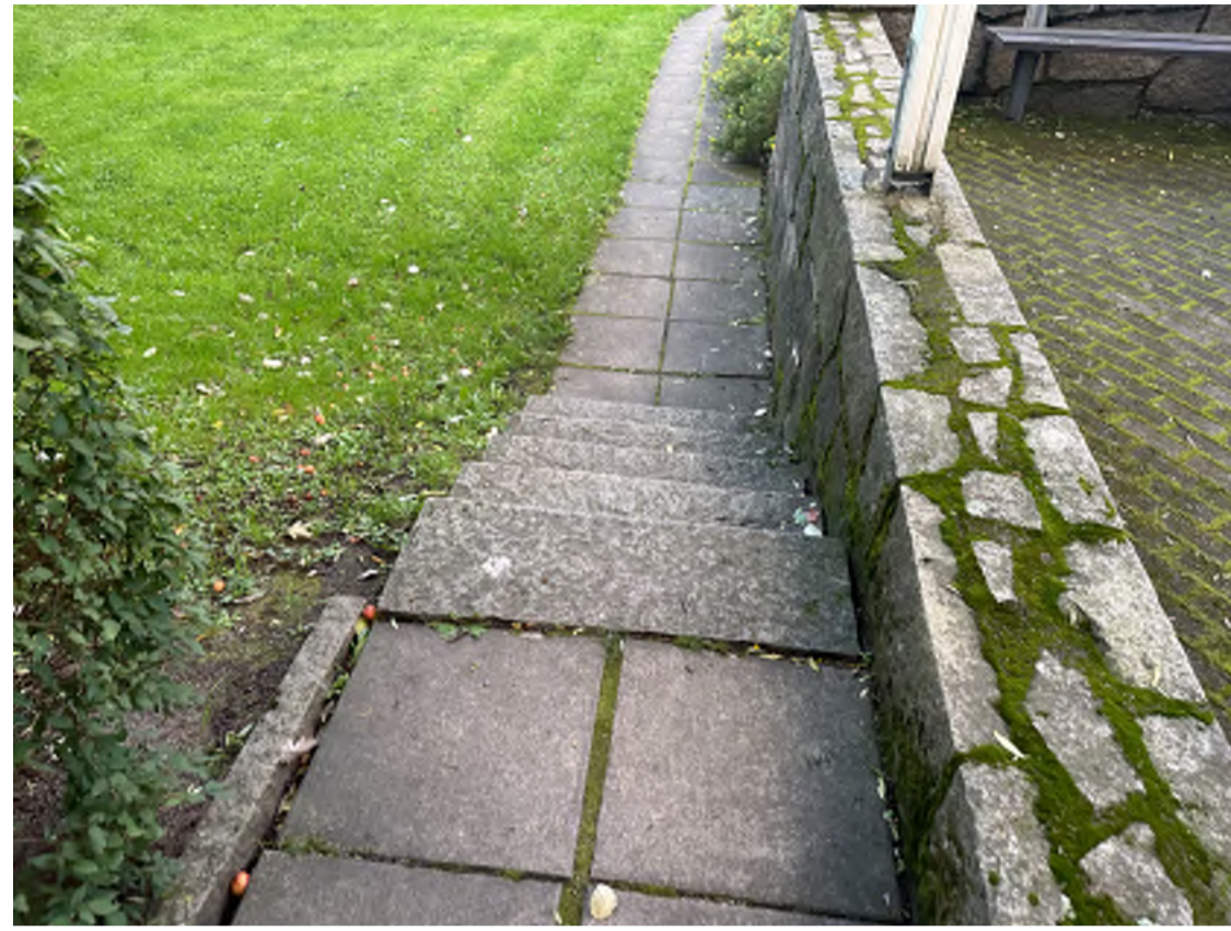
Stenmur dokumenteras, rivs varsamt, förvaras, rengörs, numreras och återbyggs på samma plats efter dränering
