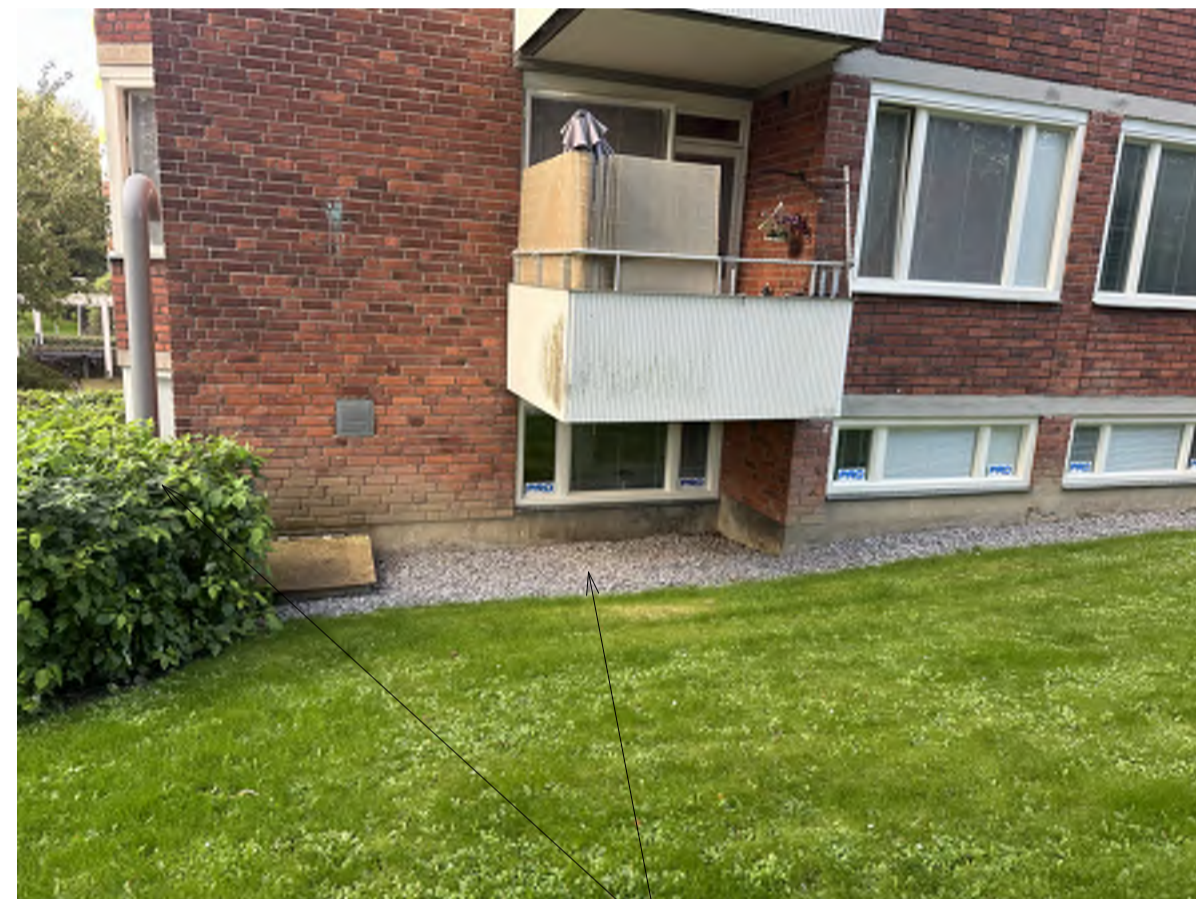
Grus, jordlager och buskage rivs runt husen i omfattning för dräneringsarbete. Mark återbyggs lika befintligt, ny plantering.
