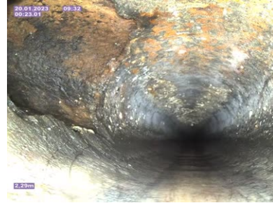
Bildnamn: 22_2_A, Videotid: 23s Grenrör, klockan 09.
