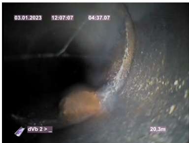
Bildnamn: 29_7_A, Videotid: 277s Fogförskjutning 3. Axiell förskjutning där fogen inte är öppen och där risk för öppen fog inte bedöms föreligga.
