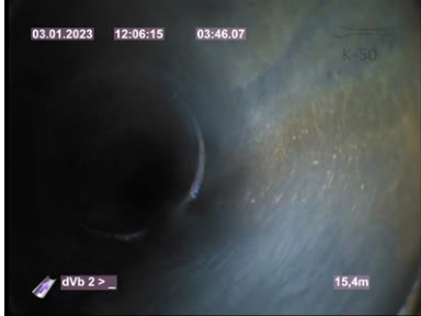
Bildnamn: 29_5_A, Videotid: 226s Materialförändring till, betong .
