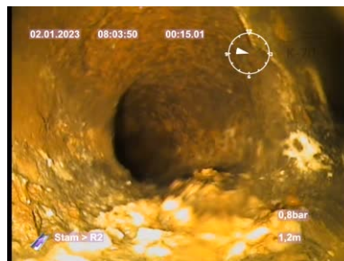
Bildnamn: 6_2_A, Videotid: 15s Grenrör, klockan 09.
