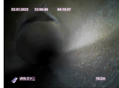
Bildnamn: 29_6_A, Videotid: 259s Fogförskjutning 3. Axiell förskjutning där fogen inte är öppen och där risk för öppen fog inte bedöms föreligga.
