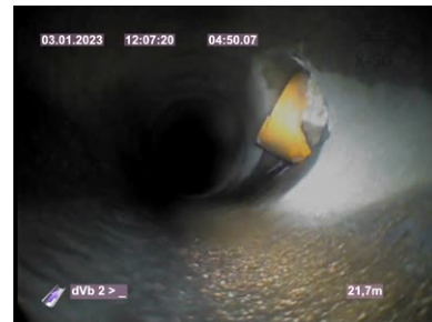
Bildnamn: 29_8_A, Videotid: 290s Inhuggen Servis 1: Inträngande <10%.
