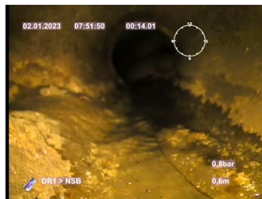
Bildnamn: 2_2_A, Videotid: 14s Grenrör, klockan 09.
