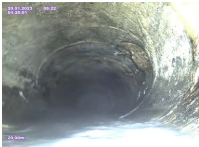
Bildnamn: 26_9_A, Videotid: 260s Grenrör, klockan 02 .
