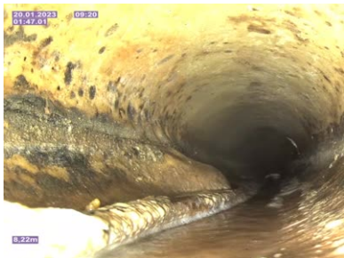
Bildnamn: 26_5_A, Videotid: 107s Bula 3. Reduktion av tvärsnittsarean på 15-30 %.
