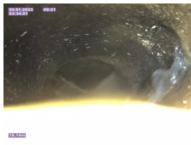
Bildnamn: 26_8_A, Videotid: 214s Grenrör, klockan 02 .
