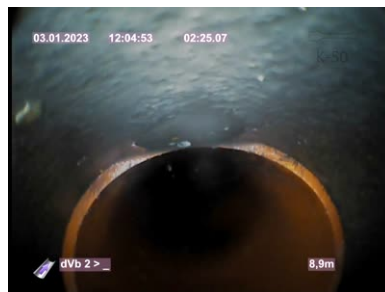
Bildnamn: 29_4_A, Videotid: 145s Materialförändring till, plast .
