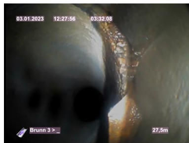
Bildnamn: 28_6_A, Videotid: 212s Fogförskjutning 3. Axiell förskjutning där fogen inte är öppen och där risk för öppen fog inte bedöms föreligga.
