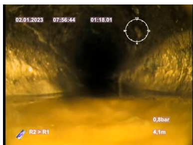
Bildnamn: 5_3_A, Videotid: 78s Vattenansamling 2. Medför en vattennivå som är från 5 % och upp till 15 % av Vattenansamling 2. Medför en vattennivå som är från 5 % och upp till 15 % av rörets invändiga höjd.
