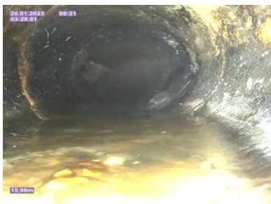
Bildnamn: 26_7_A, Videotid: 209s Vattenansamling 1. Medför en vattennivå som är mindre än 5 % av rörets invändiga höjd.
