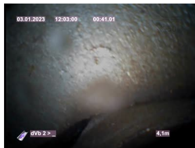
Bildnamn: 29_2_A, Videotid: 41s Fogförskjutning 3. Axiell förskjutning där fogen inte är öppen och där risk för öppen fog inte bedöms föreligga.
