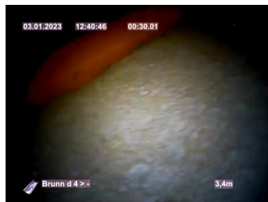
Bildnamn: 31_2_A, Videotid: 30s Materialförändring till, plast .
