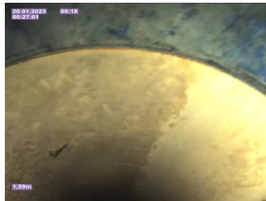
Bildnamn: 26_2_A, Videotid: 27s Materialförändring till, flexibelt foder.
