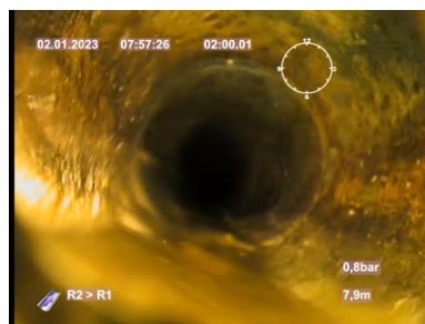
Bildnamn: 5_3_A, Videotid: 78s Vattenansamling 2. Medför en vattennivå som är från 5 % och upp till 15 % av Vattenansamling 2. Medför en vattennivå som är från 5 % och upp till 15 % av rörets invändiga höjd.
