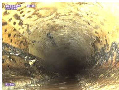
Bildnamn: 26_4_A, Videotid: 95s Vattenansamling 1. Medför en vattennivå som är mindre än 5 % av rörets invändiga höjd.
