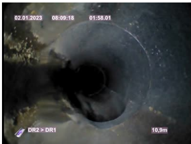
Bildnamn: 3_3_A, Videotid: 118s Grenrör, klockan 05 .
