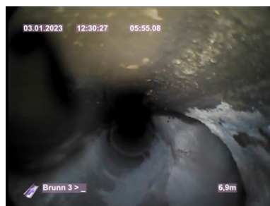
Bildnamn: 28_4_A, Videotid: 355s Grenrör, klockan 09.
