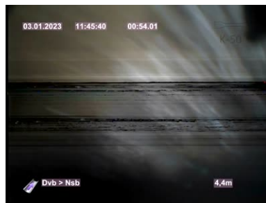
Bildnamn: 32_2_A, Videotid: 54s Sediment 2. Reduktion av rörets tvärsnittsarea som är från 5% och upp till 15%, annan .
