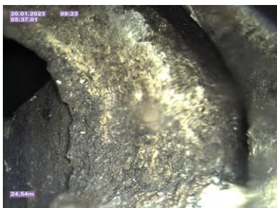
Bildnamn: 26_11_A, Videotid: 337s Materialförändring till betong .
