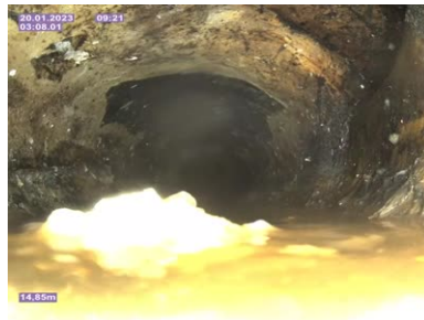
Bildnamn: 26_6_A, Videotid: 188s Grenrör, klockan 01 .
